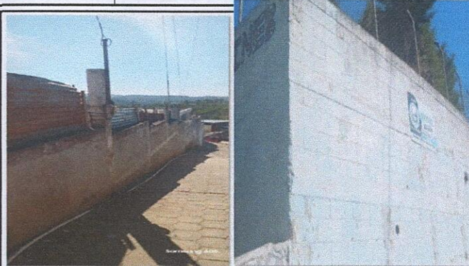
Foto 2: partes externas del establecimiento colocacion de cedazo y pintura
