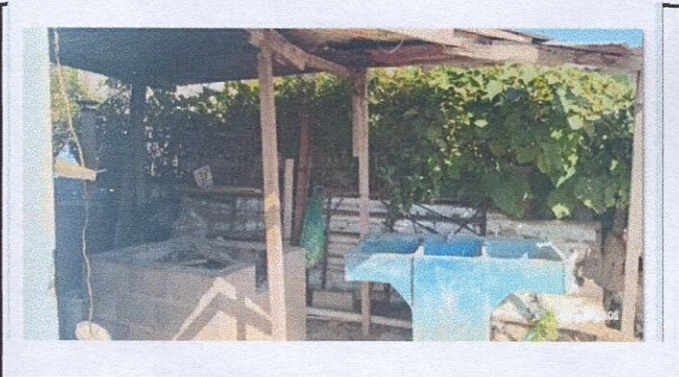
Foto 4: Mejoramiento de cocina.
