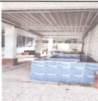
Foto 7: Instalación de estructura metálica portante y cambio de pilas a pila de concreto de 1.3 X 3.10 mts.
