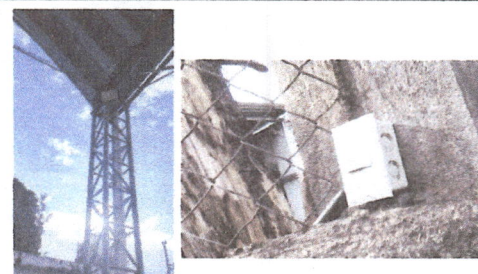
Foto 10: Instalación de Reflectores y timbre
