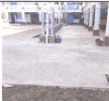
Foto 9: Instalación de losa en patios, frente a salones de clases de estudiantes.
