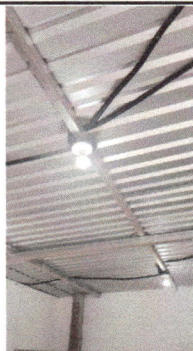
Foto 2: Ampliación de altura de pared de cocina, costaneras y cambio de techo por lamina troquelada.
