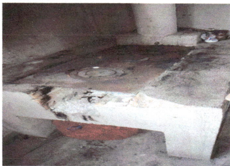
Foto 3: Reconstrucción y azulejado de planchas de cocina
