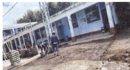
Foto 8: Instalación de estructura metálica portante en area de patio.
