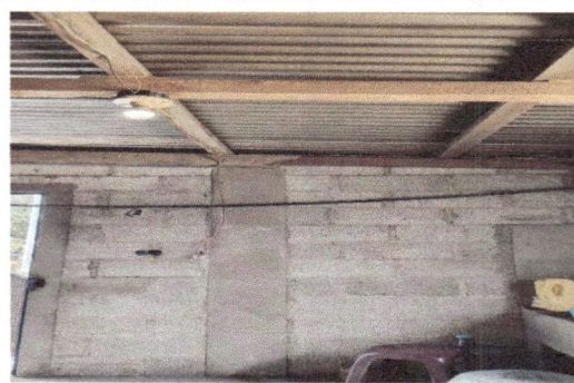
Foto 2: Ampliación de altura de pared de cocina, costaneras y cambio de techo por lamina troquelada.
