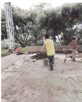
Foto 9: Instalación de losa en patios, frente a salones de clases de estudiantes.
