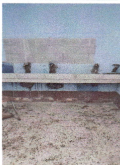
Foto 5: Cambio de lavamanos por uno de corrido y azulejado. En baños de mujeres.
