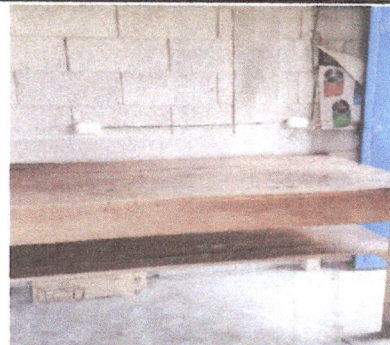
Foto 4: Construcción de mesa de concreto azulejada e implementación de corrientes de electricidad.
