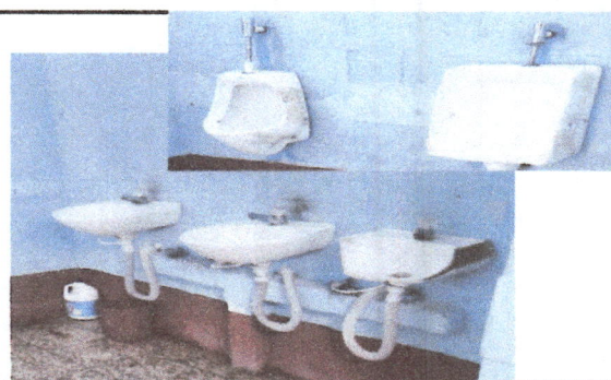
Foto 6: Cambio de lavamanos y mijitorios por uno de corrido y azulejado. En baños de varones.
