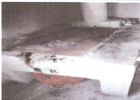
Foto 3: Reconstrucción y azulejado de planchas de cocina
