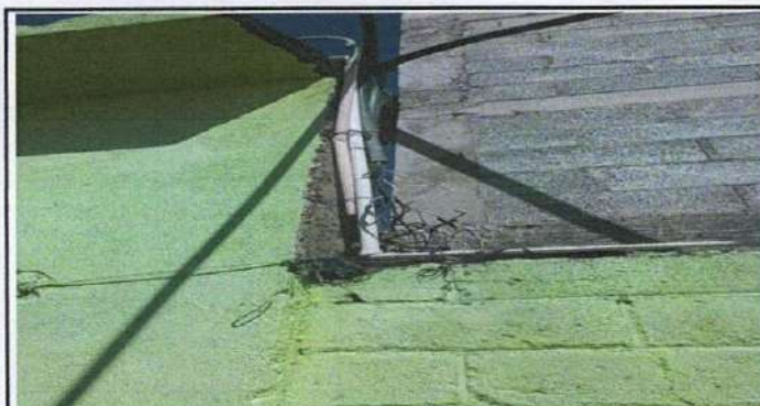
Entrada principal del sistema eléctrico
