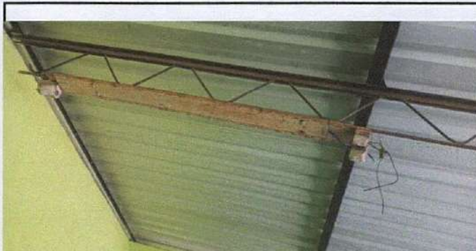
Toma corrientes todo el edificio
