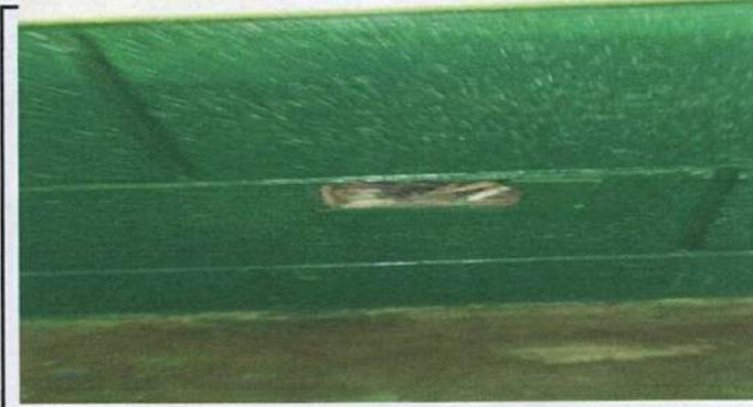
Toma corrientes todo el edificio
