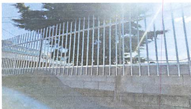
RENLÓN 3 LEVANTADO DE BLOK, NIVELACIÓN Y REJAS FRENTE A CALLE.
