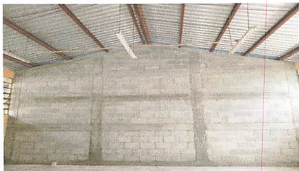
RENLÓN 1 REMOLICIÓN Y CONSTRUCCIÓN DE PARED
