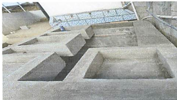
RENLÓN 2 CONSTRUCCIÓN DE PILA 2.10*1.70*.80 cms
