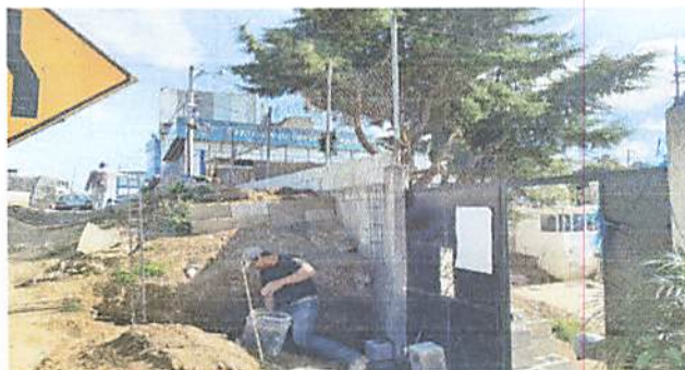
REGLÓN 3 LEVANTADO DE BLOK, NIVELACIÓN Y REJAS FRENTE A CALLE.
