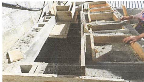
REGLÓN 2 CONSTRUCCIÓN DE PILA 2.10*1.70*.80 cms
