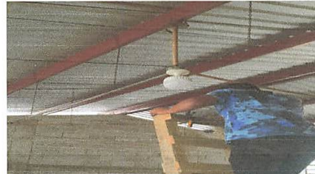
REGLÓN 4 CAMBIO DE LÁMPARAS E INSTALACIÓN DE TOMACORRIENTES
