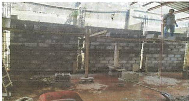
REGLÓN 1 REMOLICIÓN Y CONSTRUCCIÓN DE PARED
