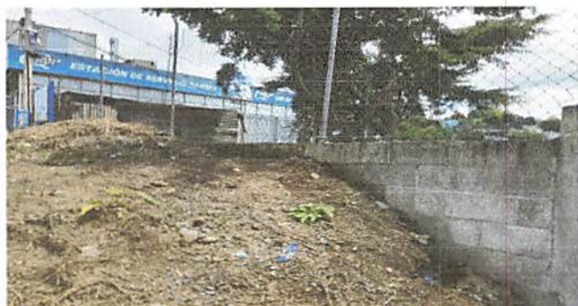
REGLÓN 3 LEVANTADO DE BLOK, NIVELACIÓN Y REJAS FRENTE A CALLE.
