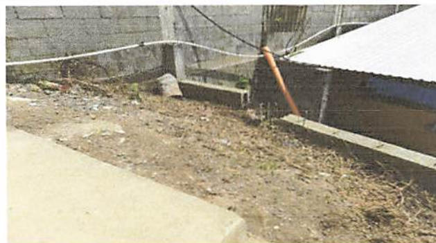
REGLÓN 2 CONSTRUCCIÓN DE PILA 2.10*1.70*.80 cms
