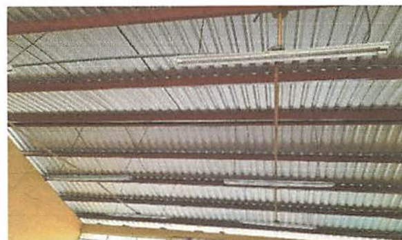
REGLÓN 4 CAMBIO DE LÁMPARAS E INSTALACIÓN DE TOMACORRIENTES
