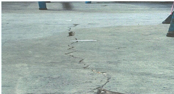
Foto 3: Cambio de Piso de concreto por piso Cerámico antideslizante en el salón de Tercero Primaria
