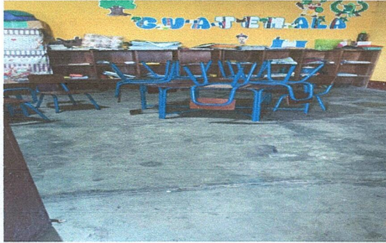
Foto 1: Cambio de piso de concreto por piso Cerámico antideslizante en el aula de Párvulos
