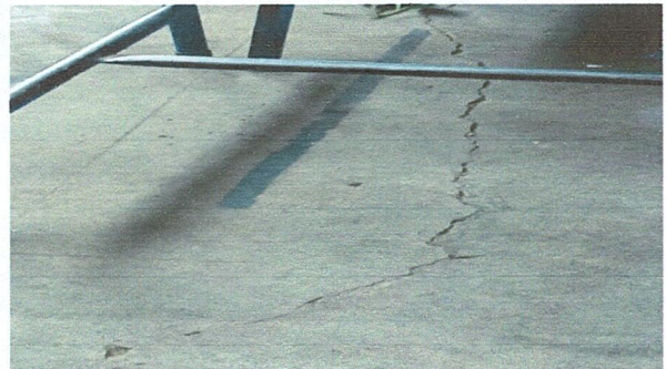
Foto 4: Cambio de piso de concreto por piso cerámico antideslizante con el salón de Primero y segundo grado
