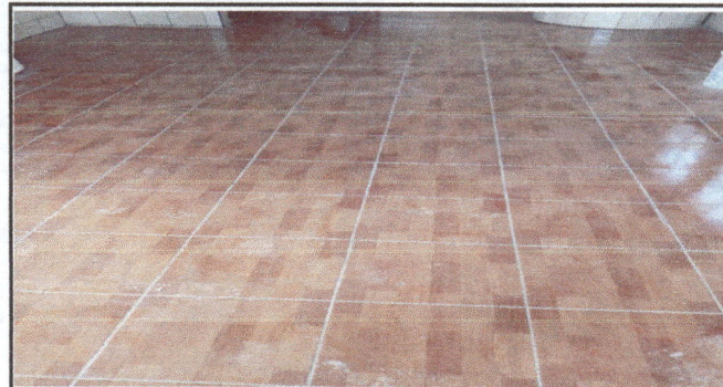
Foto 4: cambio de piso
