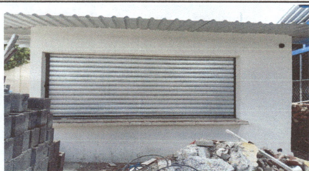
Foto 3: Instalación de persiana.
