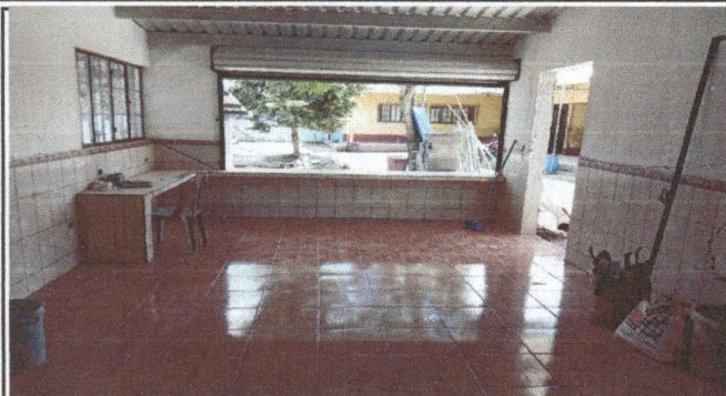
Foto1: Azulejo de paredes.
