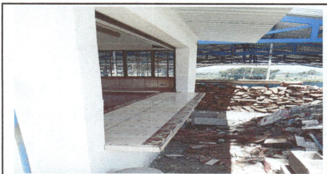
Foto 5: mesa de concreto azulejada
