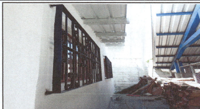
Foto 2: Colocación de balcones.
