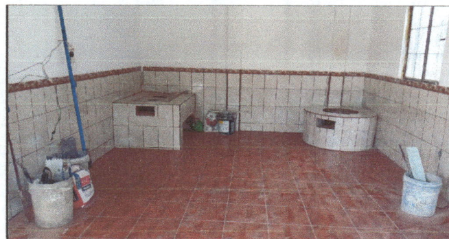
Foto 6: sustitución de poyos
