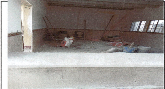
Foto 2: colocación de azulejo
