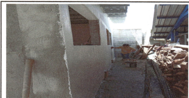
Foto 5: repello de paredes
