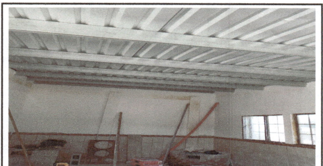
Foto 6: Cambio de techo
