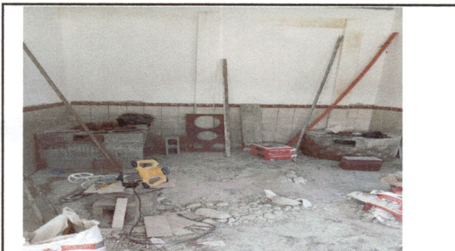
Foto 3: ampliación de lados
