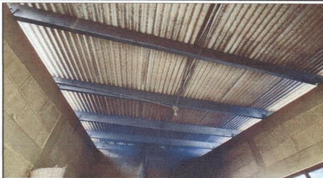
Foto 1: Cambio de techado
