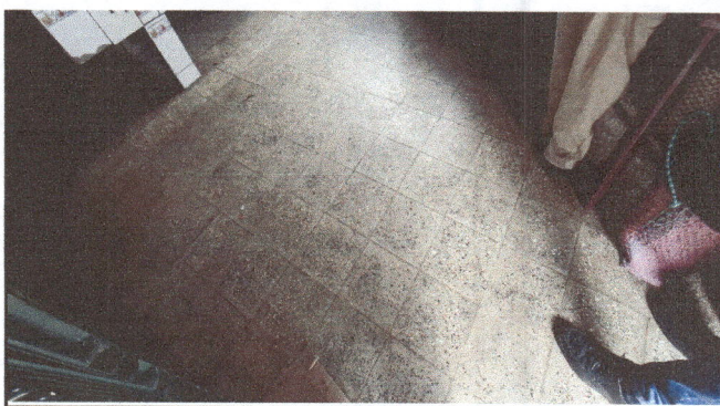
Foto 4: cambio de piso
