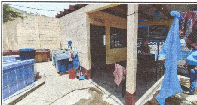
Foto 5: demolición de dos paredes y ampliación de tres lados.
