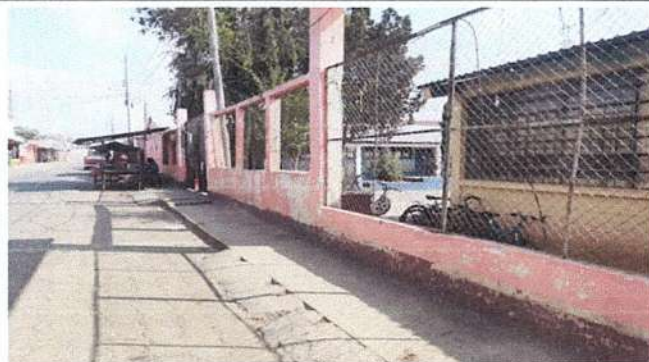
Foto 1: Reparación de muro perimetral en malas condiciones por varios años.
