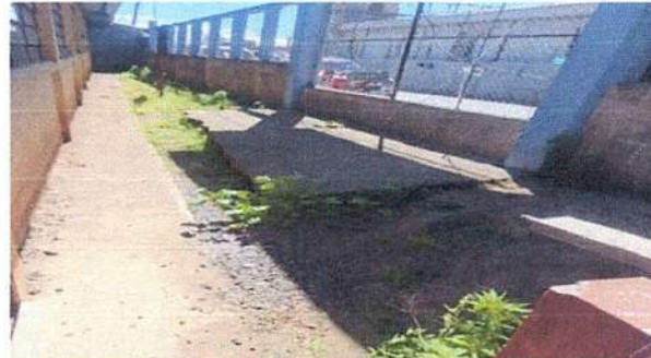
Foto 6: Reparación de pavimento, debido a que no tiene salida del agua en tiempo de invierno.
