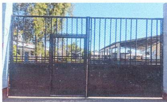
Foto 5: Sustitución e instalación de portón
