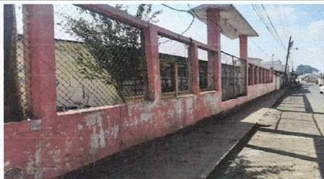
Foto 3: Sustitución de mallas en mal estado y columnas por block.
