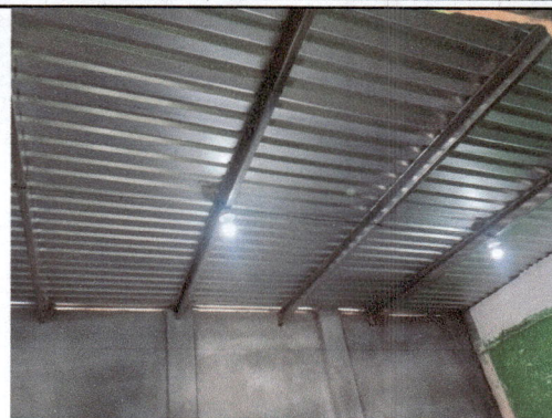
Foto 2: Muro de contención primer ambiente y cambio de techo de lamina solo en este salon se cambio costaneras de madera a metal.
