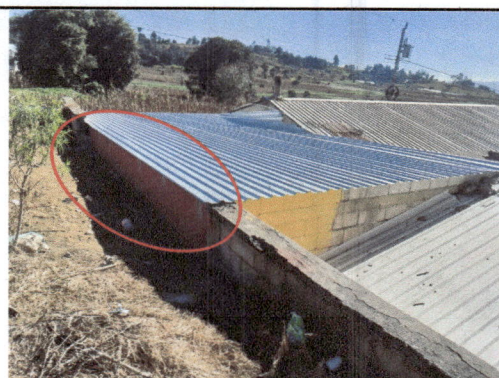
Foto 4: vista exterior del muro de contención primer ambiente e impermeabilización roja.
