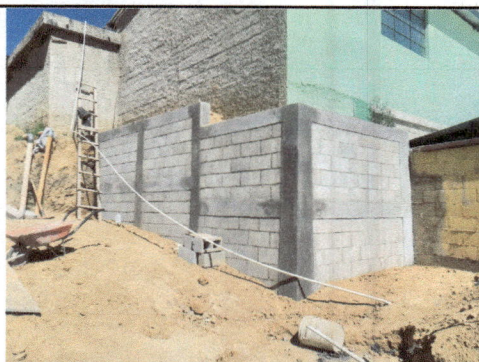
Foto 6: Muro de contención terminado segundo ambiente
