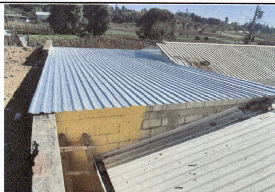
Foto 3: Cambio de techo de lamina en dos salones visto desde el exterior
