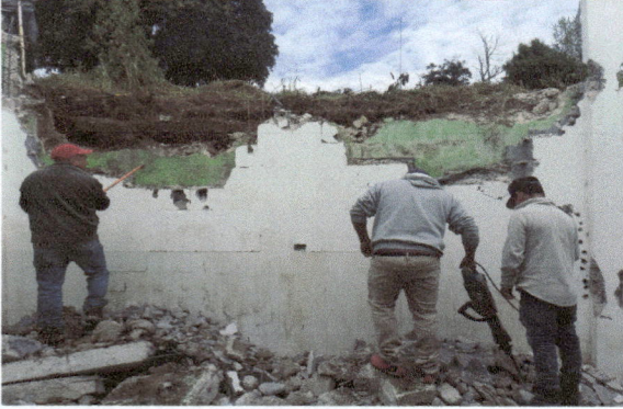
Foto 1: Demolición de dos muros desplomados por causa de aguas pluviales, primer ambiente para muro de contención.
