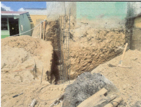
Foto 7: Cimiento de Muro de contención en ambiente No. 2.
