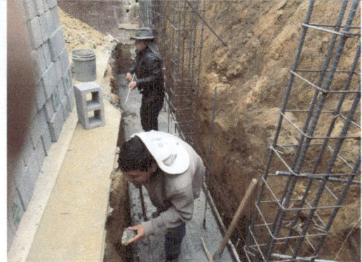
Foto 2: Cimientos del muro de contención. Primer ambiente muro de contención.
