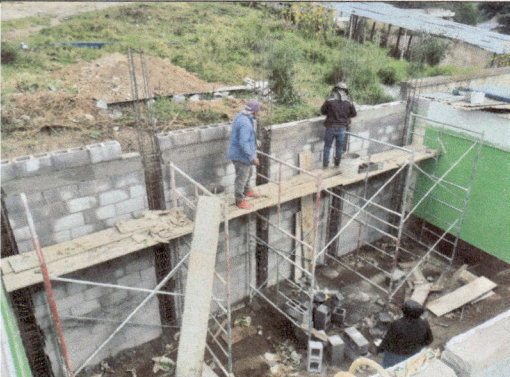
Foto 3: Se está dando la altura requerida al muro de contención.
