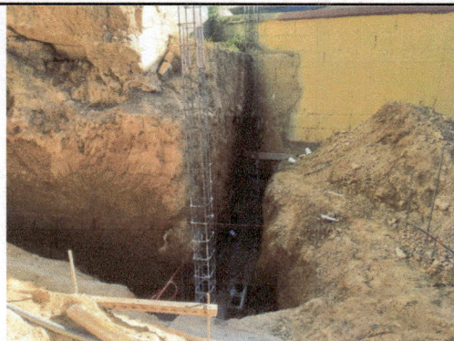
Foto 8: Cimiento de Muro de contención en ambiente No. 2.
