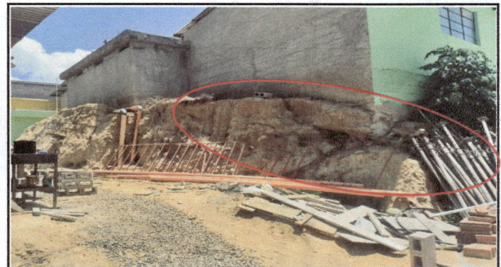
Foto 4: Muro de contención para asegurar los simientos de salon de clases (segundo ambiente)
