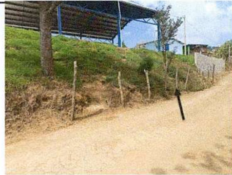
Foto 4: PROTECCION DE TALUD EN RIESGO A TRAVES DE UN MURO DE CONTENCIÓN
