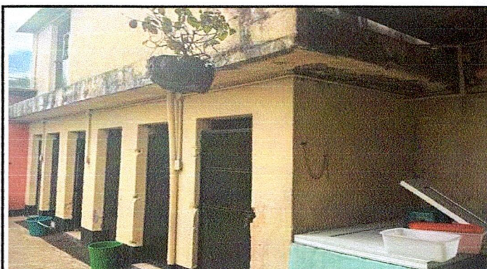
Foto 4: Mejoramiento de techo y mantenimiento a estructuras metálicas
