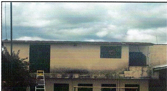
Foto 3: Mejoramiento de acabados en paredes de baños
