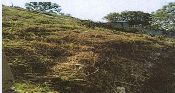
Foto 4: Seguimiento de muro
