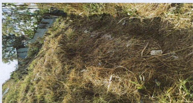
Foto 3: Parte marcado sin lamina
