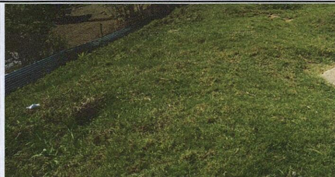
Foto 2: Deslizamiento de tierra
