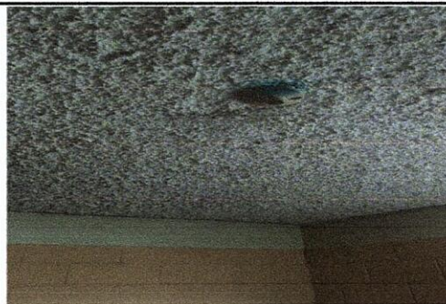
Foto 4: Reparación de la red del sistema electrico
