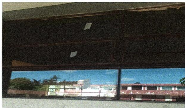
Foto 1: Sustitución de vidrios en ventanas
