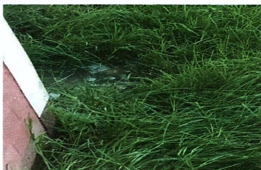
Foto 3: Reparación de red de drenaje
