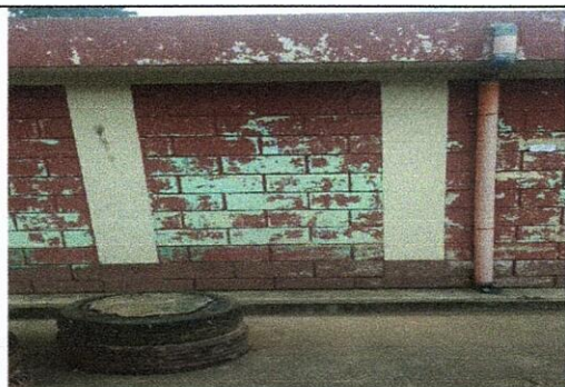
Foto 5: Aplicación de pintura en muro exterior por deterioro
