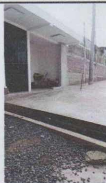
Foto 2: Rampa para el paso de los estudiantes y personas con discapacidad fisica.
