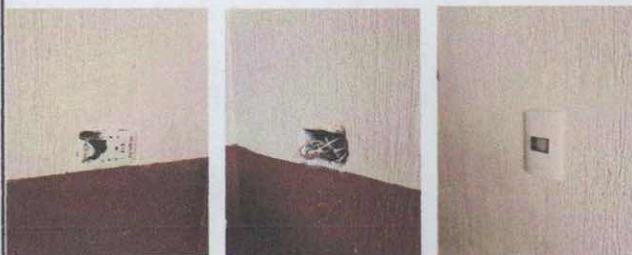
Foto 6: Tomacorrientes y switch malos en todo el establecimiento.
