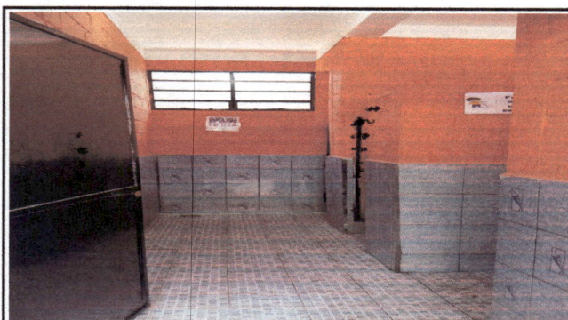
Foto 4: cambio de piso de baño
