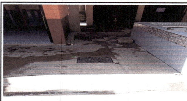
Foto 6: Reparación de concreto
