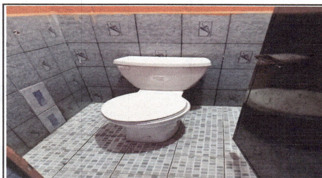
Foto 3: cambio de tazas sanitarias
