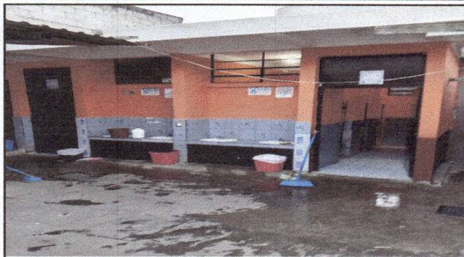
Foto 1: loza de techo y lavamanos
