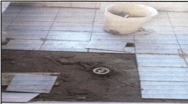
Foto 1: Colocación de azulejo en pila
