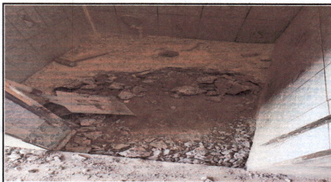
Foto 3: reparación de tubería.
