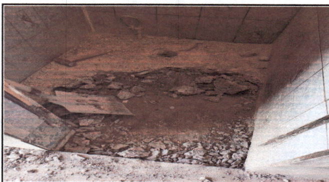
Foto 3: reparación de tubería.
