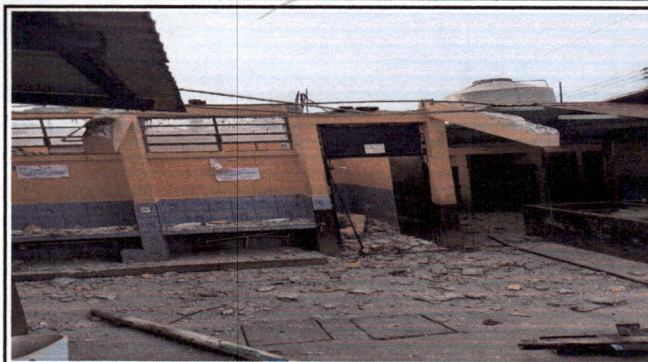
Foto 2: demolicion de techo
