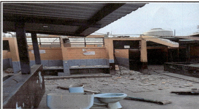
Foto 1: Demolicion de techo
