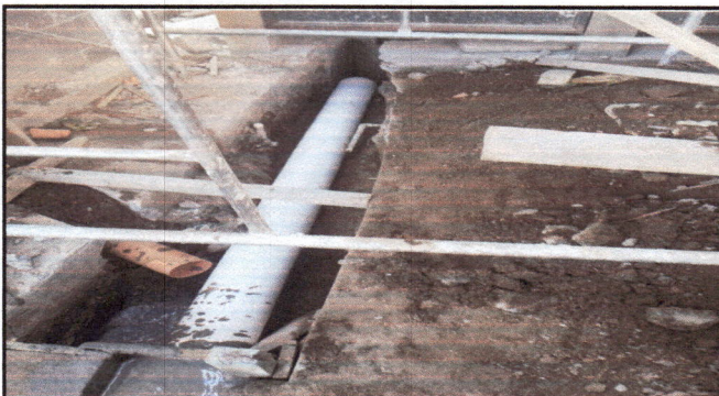
Foto 3: Cambio de drenaje
