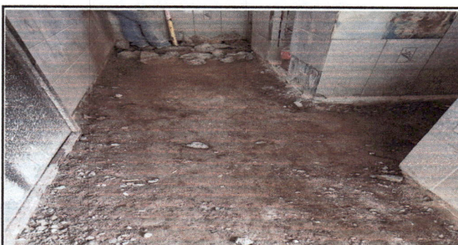
Foto 5: Reparación de piso de baños.
