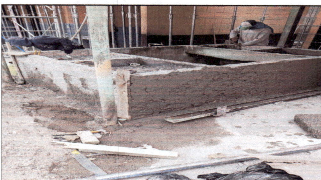
Foto 4: Repello de la pila.
