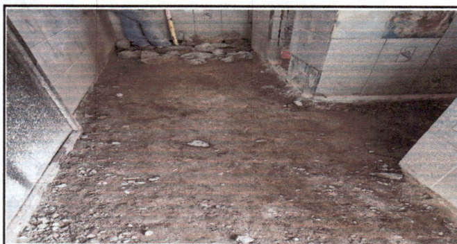
Foto 5: Reparación de piso de baños.
