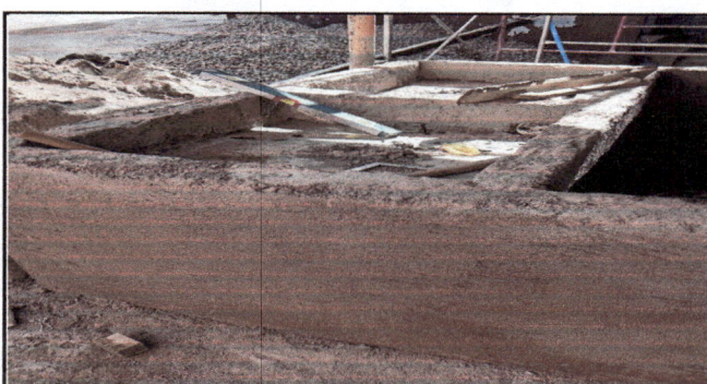
Foto 6: Refuerzo de pila.
