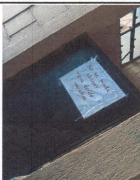
SANITARIOS Y PUERTAS EN MAL ESTADO
