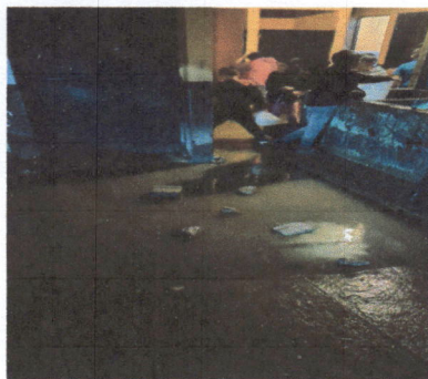
DRENAJE TAPADO POR LAS LLUVIAS
