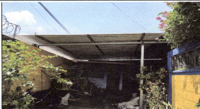
Foto 1: Ampliación de Techo de Cocina.
