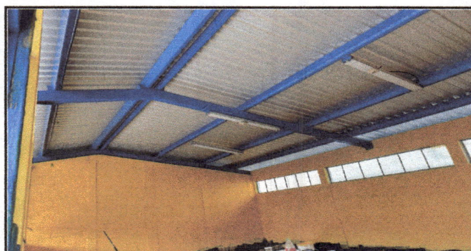
Foto 6: Aplicación de pintura de costaneras.
