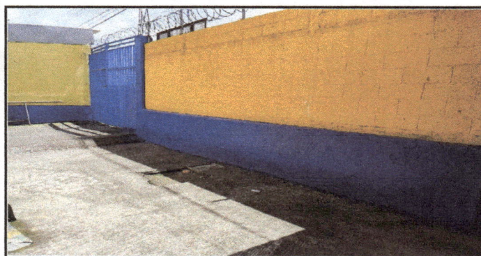
Foto 5: Aplicación de pintura.
