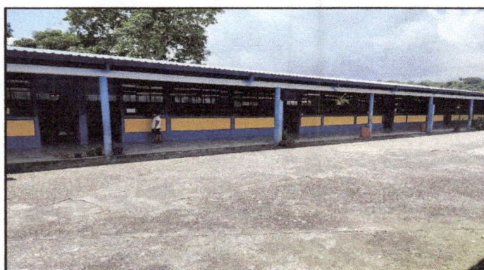
Foto 4: Aplicación de Pintura
