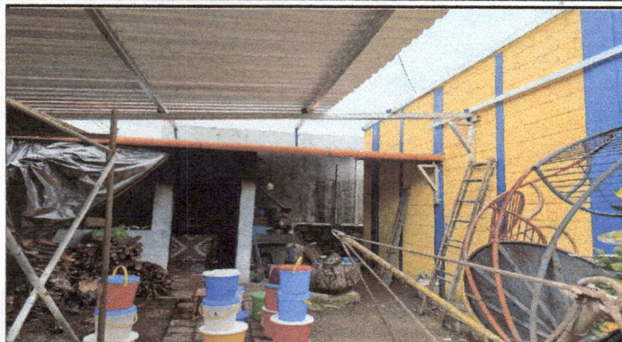
Foto 1: Ampliación de Techo de Cocina.
