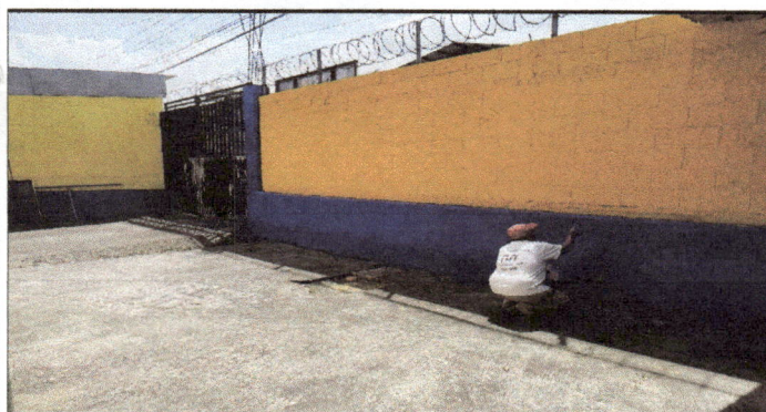
Foto 5: Aplicación de pintura.
