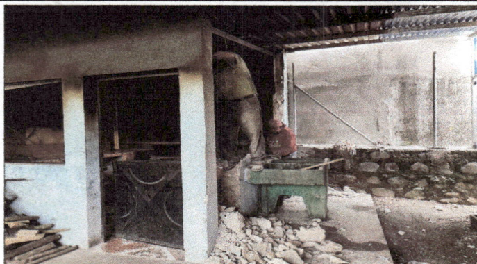
Foto 2: Demolición de pared de 3 metros.
