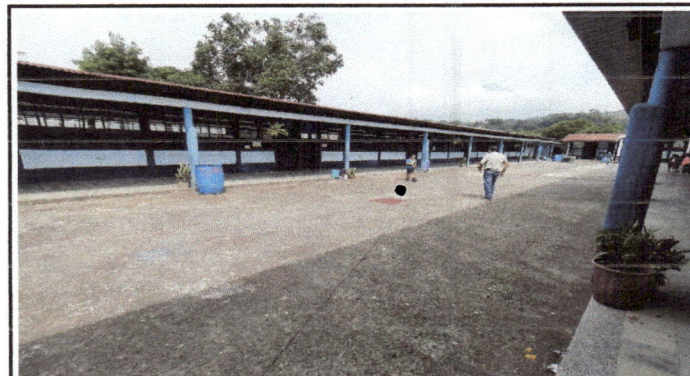
Foto 4: Aplicación de Pintura
