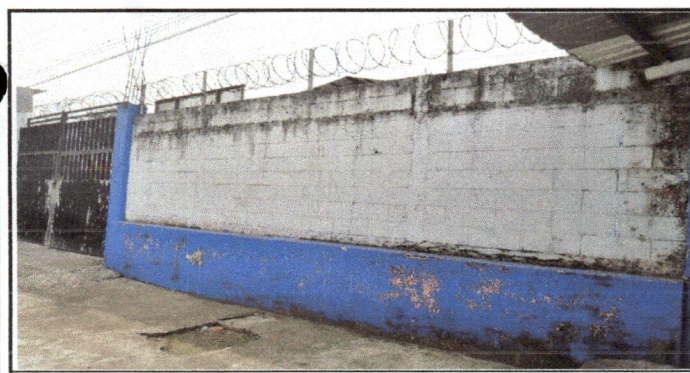
Foto 5: Aplicación de pintura.
