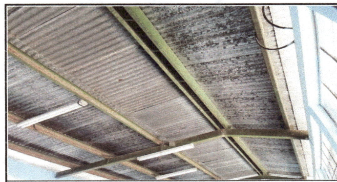
Foto 6: Aplicación de pintura de costaneras.
