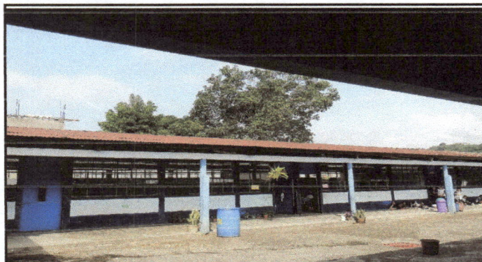
Foto 3: Suministro e instalación de techo con láminas Troqueladas.
