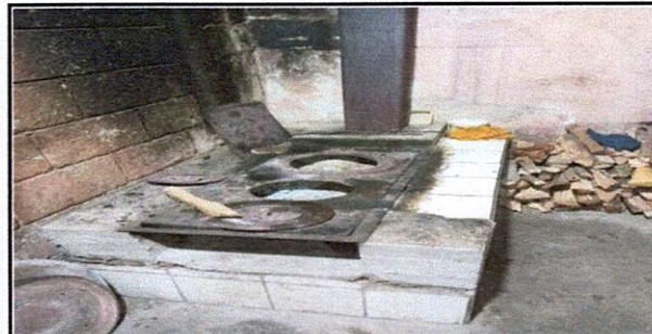
Foto 6: plancha y pollo en mal estado
