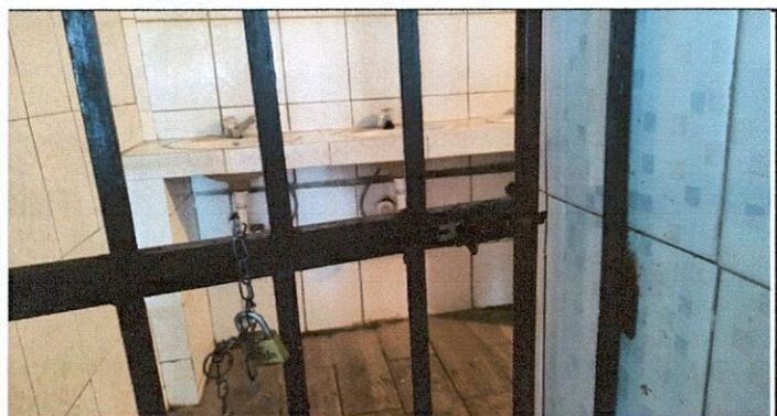
Foto 3: Instalación de chapas en las puertas de los baños
