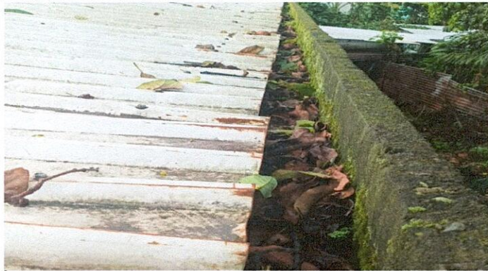
Foto 2: Reparación de Canal
