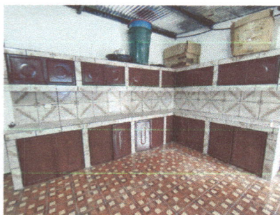
Foto19: Azulejado de gabinetes areos y mesa de cemento
