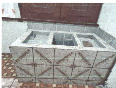
Foto 17: Azulejado de pila de cemento de dos lavaderos.
