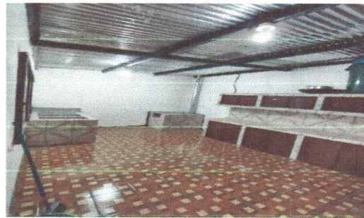
Foto 2: Sustrucion de piso de torta de concreto a piso ceramico (cocina)
