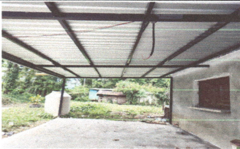
Foto 9: estructura metalica para techo
