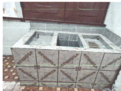
Foto 16: Fabricacion de pila de cemento de dos lavaderos
