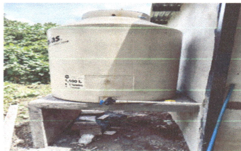
Foto 14: Fabricacion de plancha de para de deposito de agua de 1100lt
