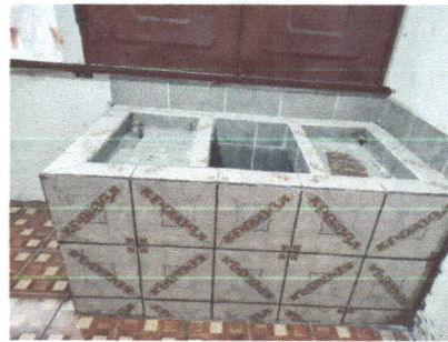
Foto 20: Azulejado de pila de cemento de dos lavaderos.
