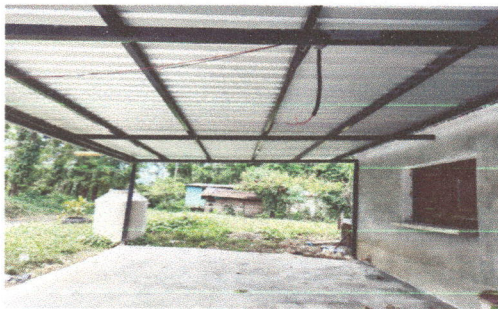
Foto 3: Elaboracion planchas de concreto de patio
