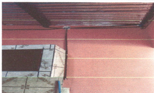
Foto 13: Instalacion de tomacorriente doble
