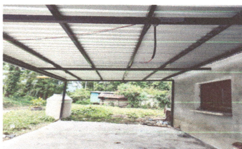
Foto 15: Elaboracion planchas de concreto de patio
