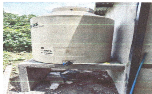
Foto 6: Sustrucion de deposito de agua de 1100 lt
