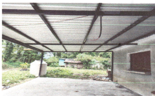
Foto 18: Recubierta de estructura metalica con laminas troquelada
