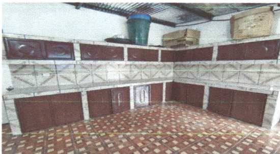
Foto 11: Fabricacion de mesa de cemento
