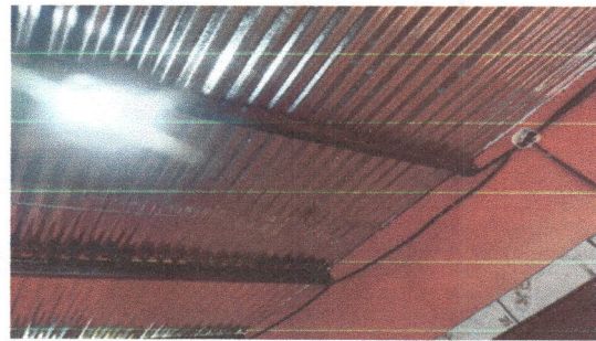
Foto 4: Instalacion cableado electrico
