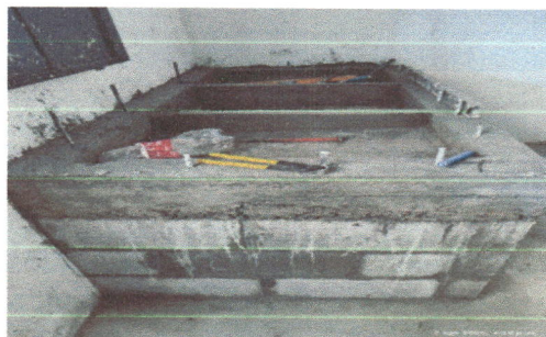
Foto 16: Fabricacion de pila de cemento de dos lavaderos
