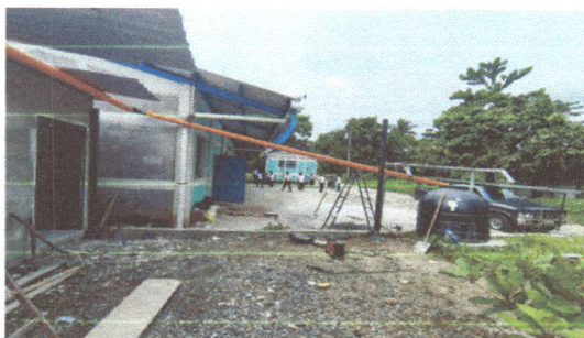
Foto 15: Elaboracion planchas de concreto de patio
