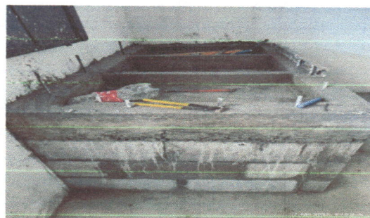
Foto 8: Fabricacion de pila de cemento de dos lavaderos
