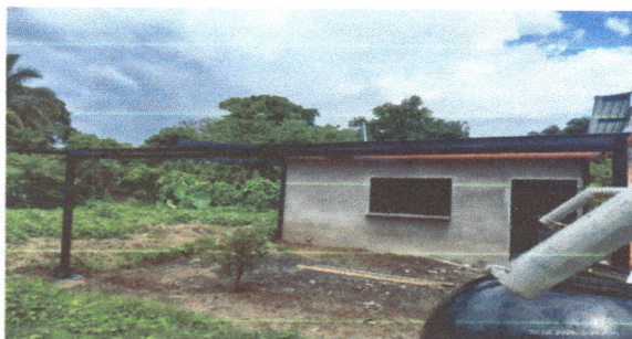
Foto 9: estructura metalica para techo
