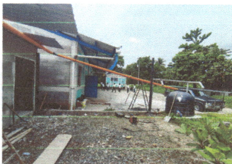
Foto 3: Elaboracion planchas de concreto de patio
