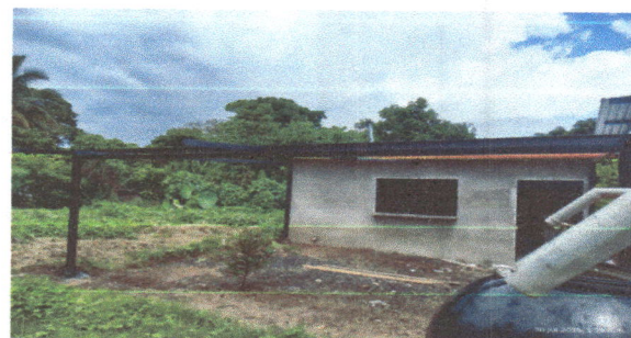
Foto 12: nstalacion de drenaje y chorro de agua
