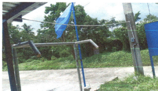
Foto 4: Instalacion cableado electrico
