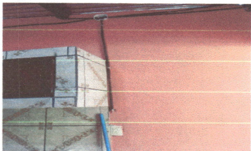
Foto 13: Instalacion de tomacorriente doble
