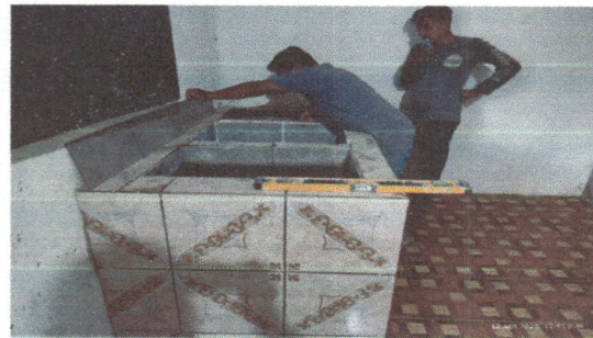
Foto 20: Azulejado de pila de cemento de dos lavaderos.
