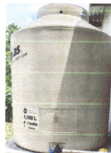
Foto 6: Sustrucion de deposito de agua de 1100 lt
