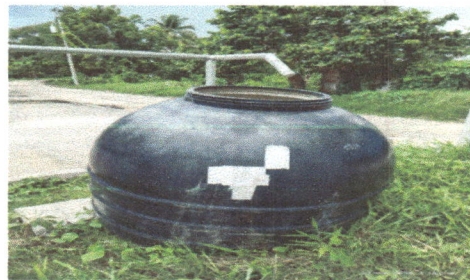
Foto 6: Sustitución de depósito de agua de 1100 lt
