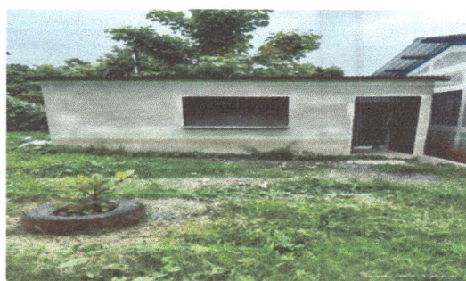
Foto 18: Recubierta de estructura metalica con laminas troquelada
