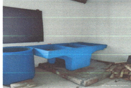
Foto 8: Fabricacion de pila de cemento de dos lavaderos
