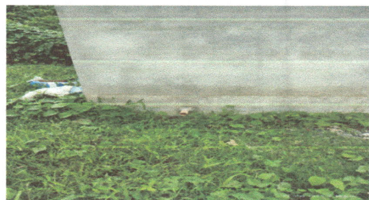
Foto 12: nstalacion de drenaje y chorro de agua
