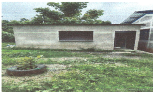
Foto 15: Elaboracion planchas de concreto de patio
