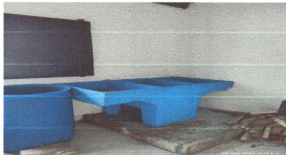
Foto 20: Azulejado de pila de cemento de dos lavaderos.
