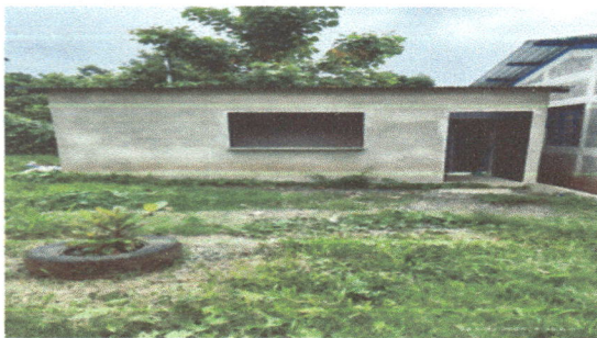
Foto 9: estructura metalica para techo
