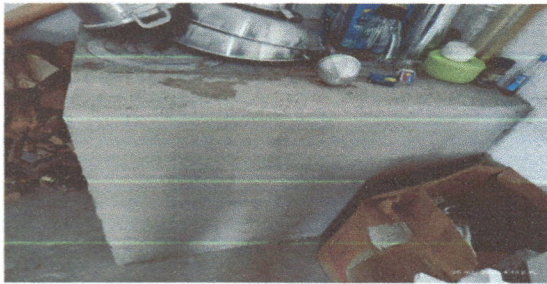
Foto 7: Instalacion de azulejo de estufa rural
