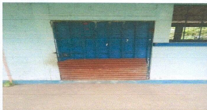
Foto1: REMOZAMIENTO DE PUERTA DE REJAS
