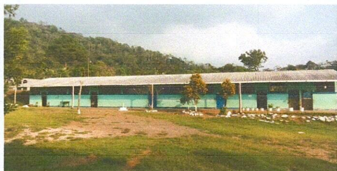
Foto 2: SUSTITUCIÓN Y APLICACIÓN DE PINTURA EN TODA LA ESCUELA
