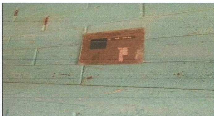
Foto 6: SUSTITUCIÓN DE CAJA POR DETERIORO Y VOLTAJE
