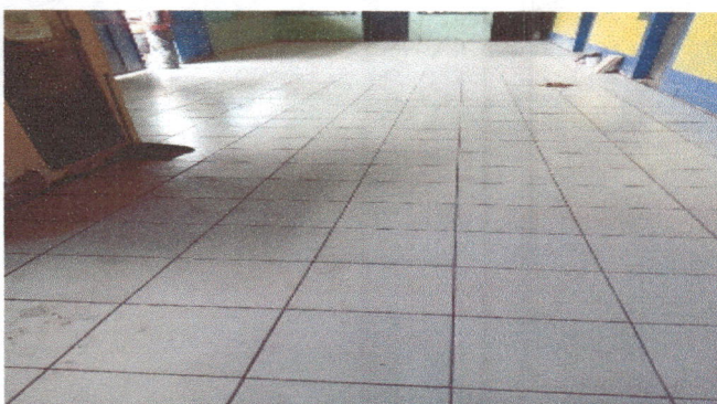
colocacion de contra piso e instalacion de piso
