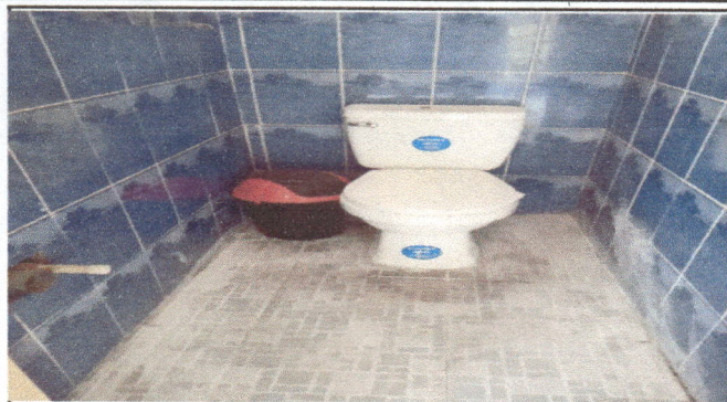
instalacion del baño
