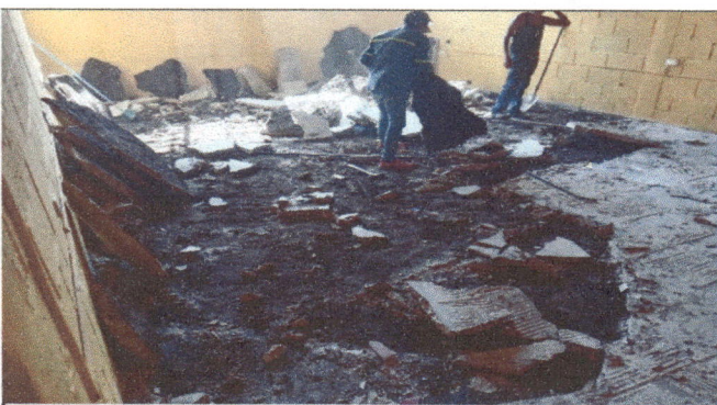
cambio del contra piso
