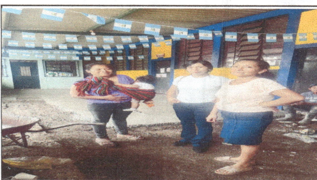
colocacion del contra piso
