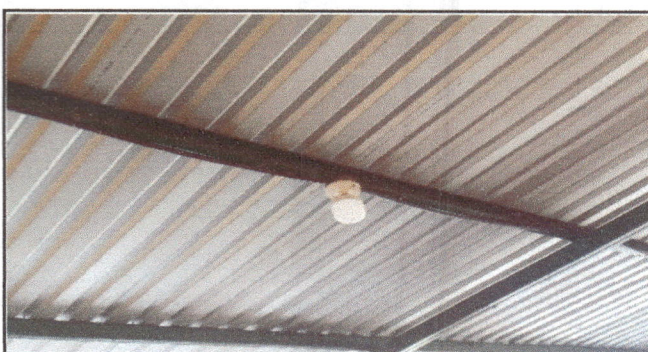
cambio de plafoneras
