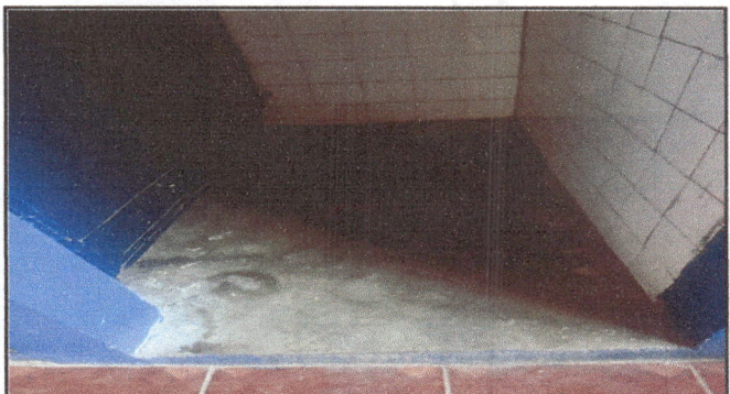
instalacion de piso y kits para baños
