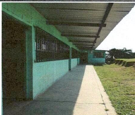
Foto 4: Espacio para colocación de rampa y barandal que conecta a cancha y cocina
