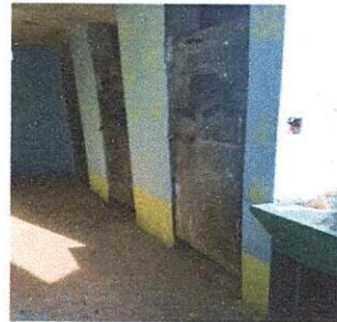
Foto 2: Mejoramiento de Sanitario
