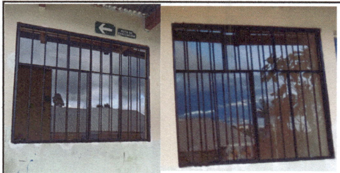
Foto 6: terminación de nuevas ventanas corredizas en uno de los salones de clases.
