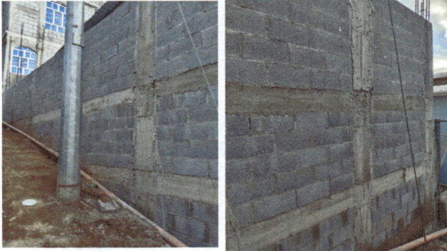
Foto 1: culminación de mantenimiento correctivo de muro existente con un muro de contención
