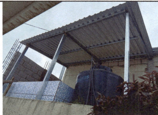
Foto 4: terminación de techo de pila
