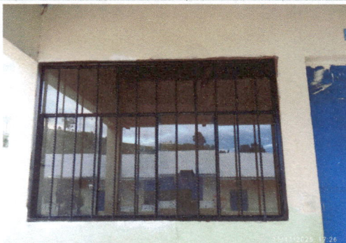
Foto 5: terminación de vetanas fijas por ventanas corredizas en la dirección.
