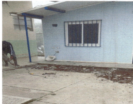
Foto 2: trabajo de quitado de losa por hundimiento frente a los baños
