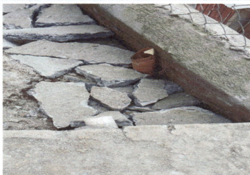
Foto 3: hundimiento de losa del lateral derecho de los baños, eliminación de losa existente
