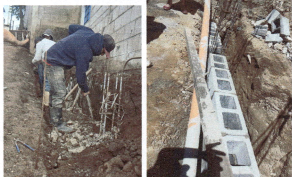
Foto1: Eliminación de pared existente y construcción de pared nueva.
