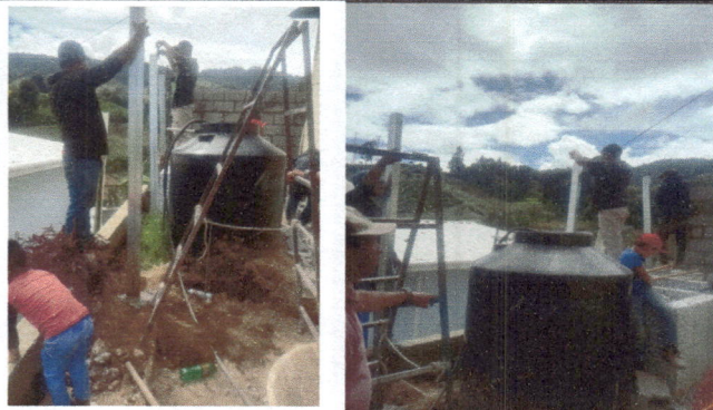
Foto 4: Elaboración de techado de pila
