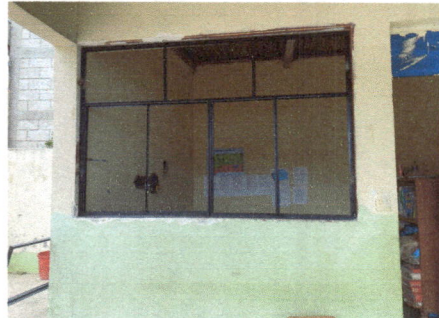
Foto 6: trabajo en colocación de ventana en dirección de la escuela
