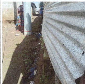
Foto1: muro perimetral y socavamiento
