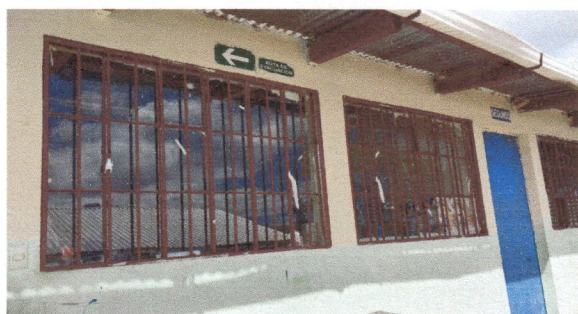
Foto 5: sustitucion de 2 ventanas fijas a movibles de un salon de clases
