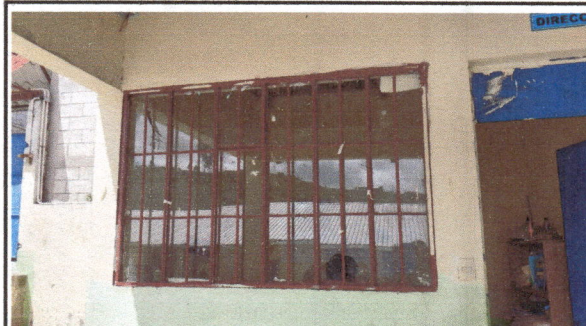
Foto 6: sustitucion de tres ventanas fijas por tres ventanas corredizas para mejor ventilación para los estudiantess.
