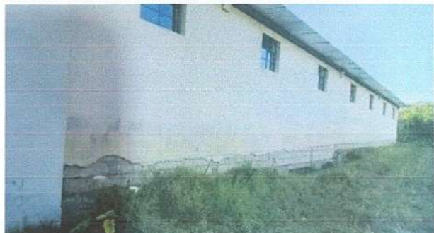
Foto 1: Espacio a trabajar, muri reforzado, para protección de aulas.
