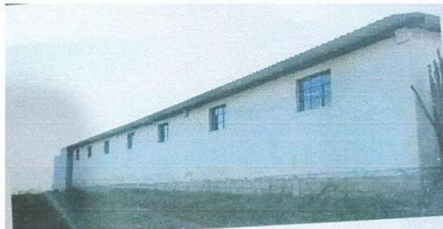
Foto 2: Levantado de banqueta, repello y cernido (altura .75) con el muro de contención
