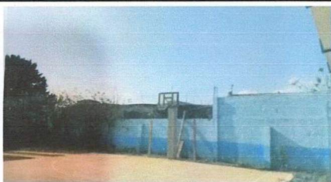
Foto 3: Seguimiento de pared cernido, repello y colocación de malla.
