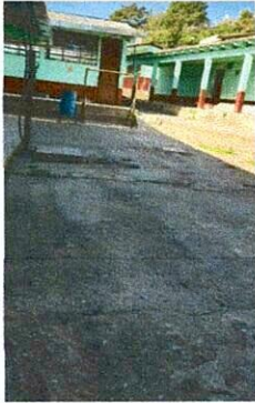
Foto1: Pavimento entrada de portón y patio
