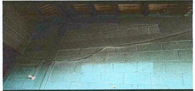
Foto 2: Instalación de 50 metros lineales de cable eléctrica para la cocina
