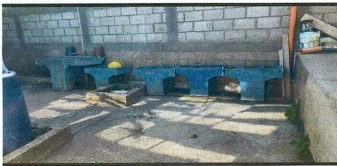
Foto 5: Construcción de 5 lavamanos
