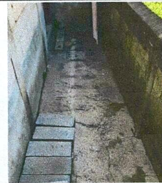
Foto 6: Continuación de levantado de 10 m2 de pared, adaptación de canales
