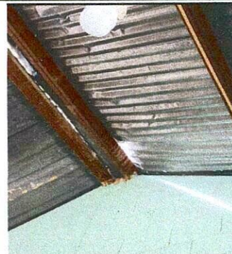
Foto 4: Sustitución de láminas en mal estado
