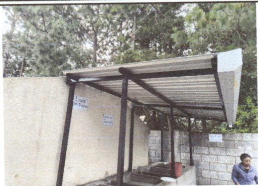
Foto1: instalación final del techo de la pila para resguardar el área.
