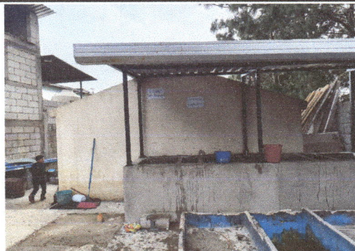
Foto 5: construcción terminada de una pila con cuatro lavaderos.
