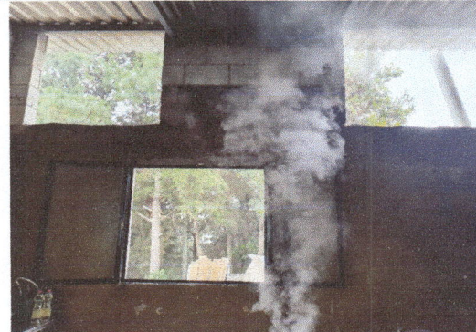
Foto 4: Finalización de las ventanas para mejor ventilación e iluminación.
