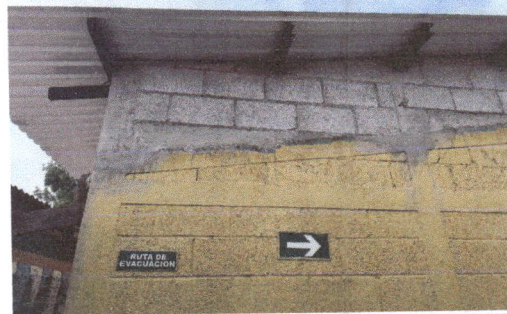
Foto 2: culminación del techo del salón de primero B. Para mejorar la ventilación y reducir la acumulación de calor, vista externa.
