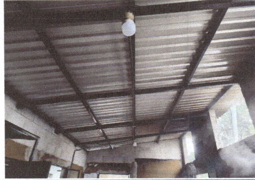
Foto 2: presentación del nuevo techo de la cocina.
