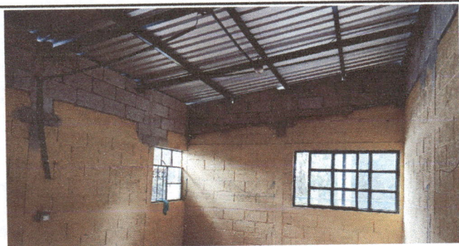
Foto 3: finalización del levantamiento del techo del salón de primero B. Para mejorar la ventilación y reducir la acumulación de calor, vista interna.
