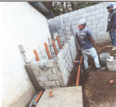
Foto 5: Avances de la construcción de una pila.
