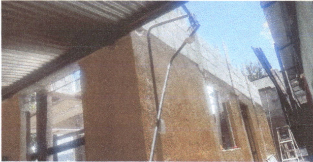
Foto 1: Continuación de trabajos de techado a la actual de la cocina para mejorar la ventilación y reducir la acumulación de calor.
