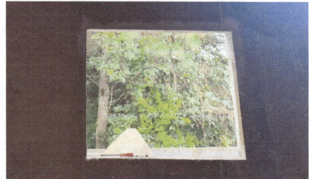
Foto 4: Avances de ampliación de ventanas para mejor ventilación e iluminación.
