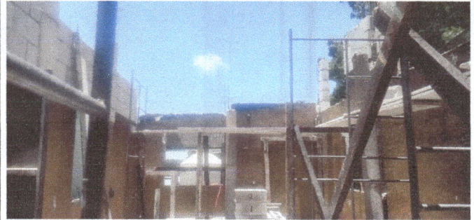
Foto 2: Trabajos durante el cambio del techado actual de la cocina.
