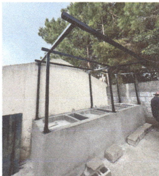
Foto1: Proceso de la instalación del techo de la pila para resguardar el área.
