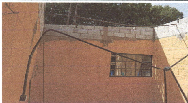
Foto 3: Proceso del trabajo del techo del salón de primero B. Para mejorar la ventilación y reducir la acumulación de calor, vista interna.
