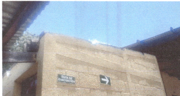
Foto 2: Continuación de trabajos del techo del salón de primero B. Para mejorar la ventilación y reducir la acumulación de calor, vista externa.
