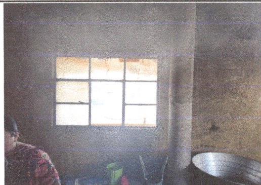
Foto 4: ampliación de ventanas para mejor ventilación e iluminación.
