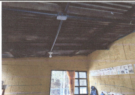
Foto 3: levantamiento del techo del salón de primero B. Para mejorar la ventilación y reducir la acumulación de calor, vista interna.
