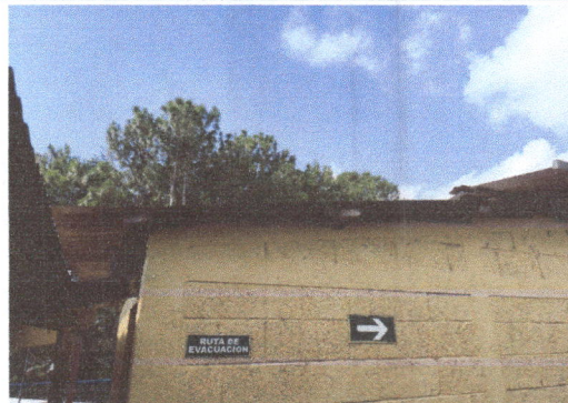
Foto 2: levantamiento del techo del salón de primero B. Para mejorar la ventilación y reducir la acumulación de calor, vista externa.
