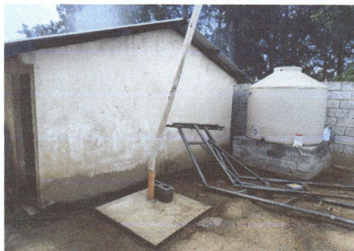
Foto 1: instalación de un techo de la pila para resguardar el área.
