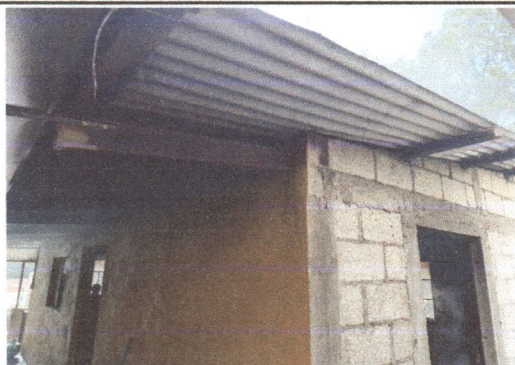
Foto 1: levantamiento de techado actual de la cocina para mejorar la ventilación y reducir la acumulación de calor.
