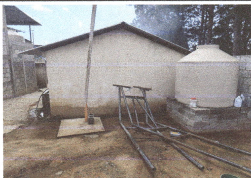
Foto 5: construcción de una pila.
