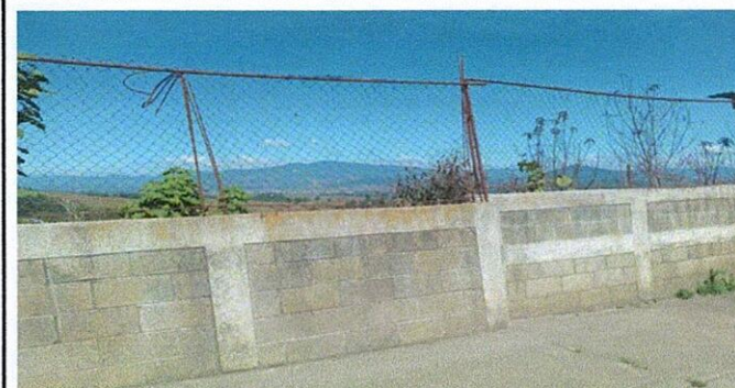
Foto 4: culminación de muro perimetral.
