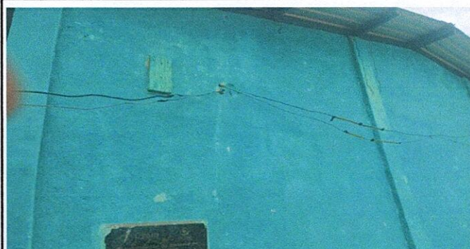
Foto2: reparación de energía eléctrica fuera de los salones
