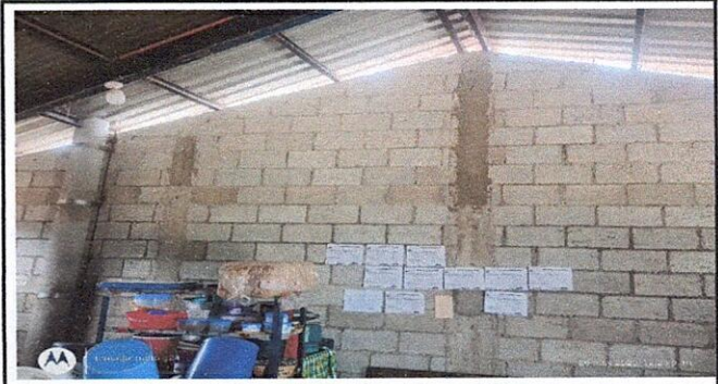
Foto 2: Colocación de gabinete 1 aéreo, no encajonado
