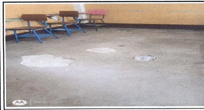
Foto 5: Sustitución de piso y colocación de zócalo, segundo nivel
