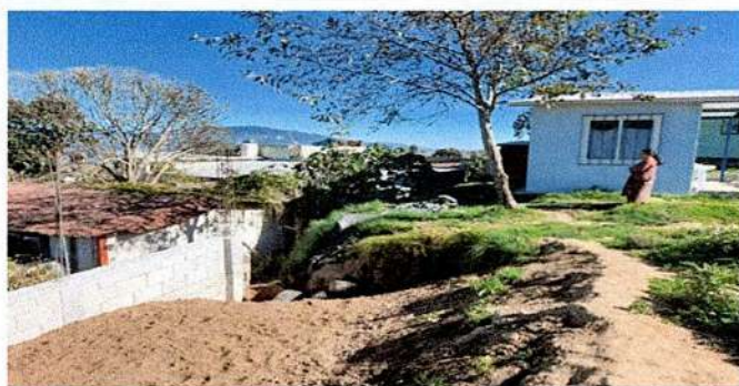
Foto 5: Muro de Contención
