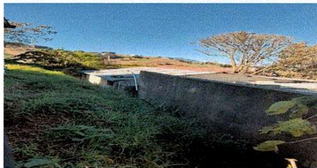
Foto 6: Muro de Contención
