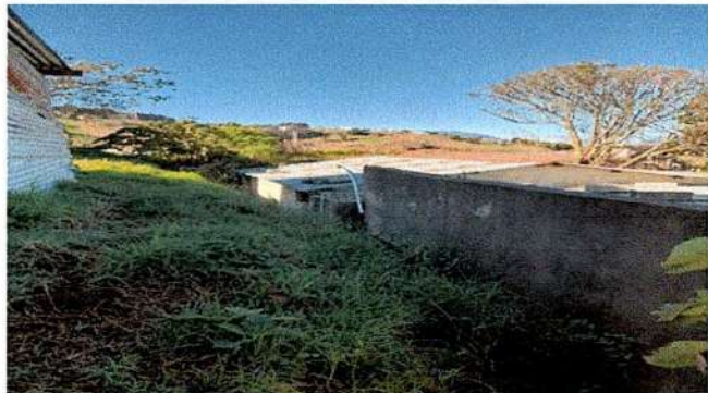
Foto 1: Muro de Contención
