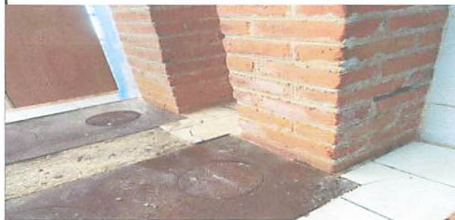
Foto 6: Reparacion de las dos chimeneas
