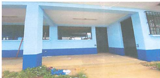
Foto 5: Pintura en muros exterior e interior de aulas.
