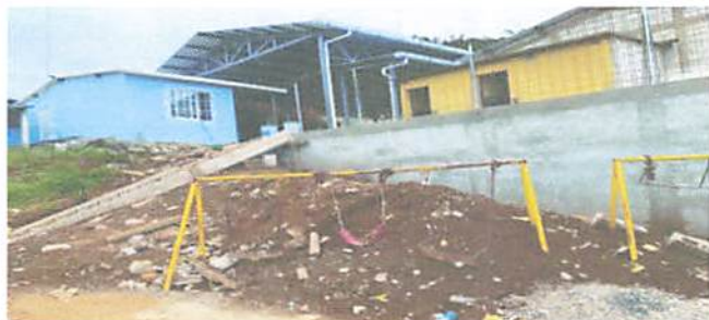
Foto1: culminacion del muro de contención, aplicado de sabieta en muro y hechura de gradas.
