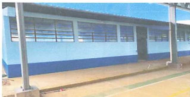
Foto 3: Pintura en exterior e interior y sellado bajo techo de aulas.
