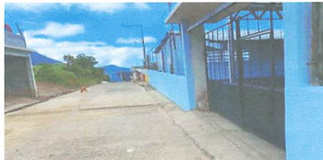
Foto 2: Cernido y pintura en muro de exterior e interior pares de calle.
