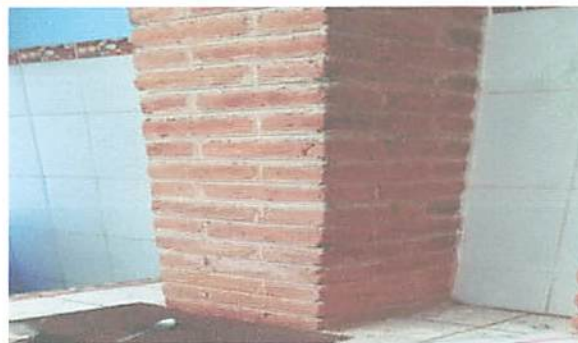
Foto 6: Reparacion de las dos chimeneas.
