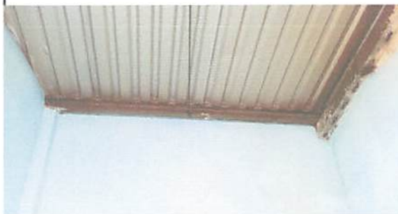
Foto 4: Pintura en exterior e interior y sellado bajo techo de cocina.
