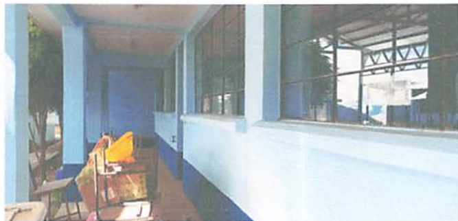
Foto 5: Pintura en muros exterior e interior de aulas.
