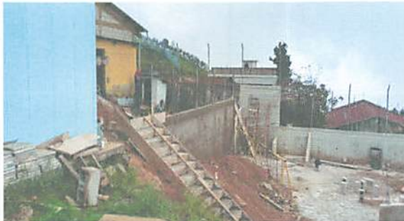
Foto1: continuacion del levantado de muro de contencion, gradas
