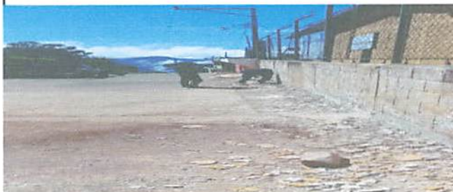
Foto 2: Cernido y pintura en muro de exterior e interior pares de calle.
