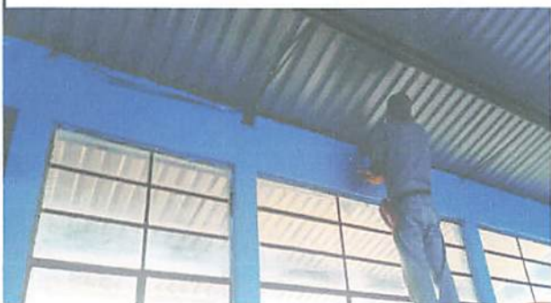
Foto 3: Pintura en exterior e interior y sellado bajo techo de aulas.
